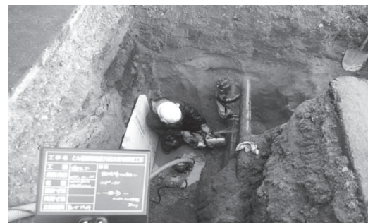
とん田東町地区外配水管布設替工事(その2)
