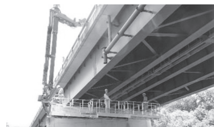
橋梁点検業務(オホーツク管内)
