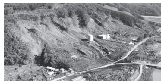
災害復旧(厚真町)
