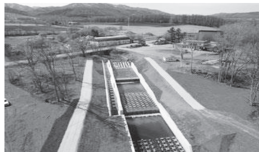
佐呂間別川広域河川改修工事(補正)(繰越)外
