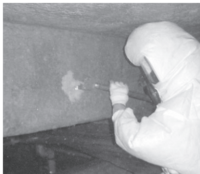
アスベスト除去工事
