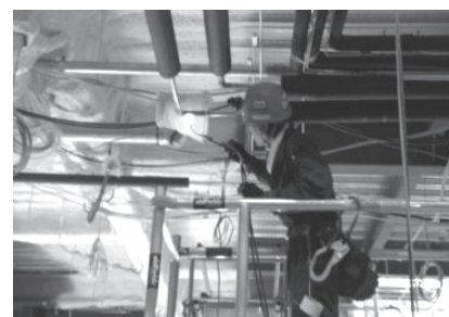
冷媒配管溶接状況(高所作業)
