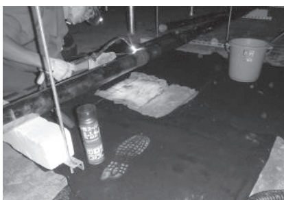
冷媒配管溶接状況(銅管)
