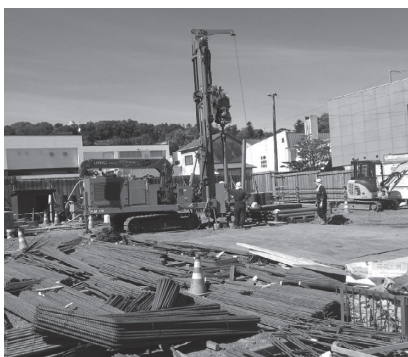
地中熱ヒートポンプ工事
