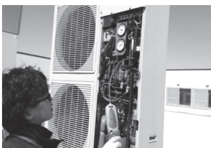
フロンガス漏れ点検状況
