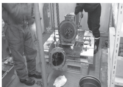
冷凍機オーバーホール状況
