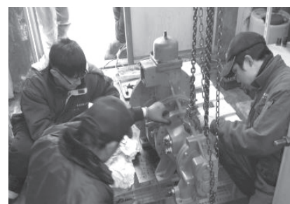
冷凍機オーバーホール組立完了
