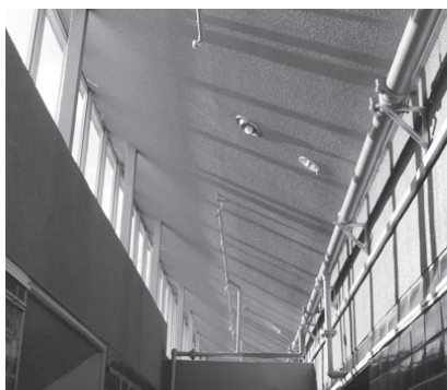
スプリンクラー設備工事
