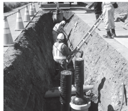
配水管布設替工事
