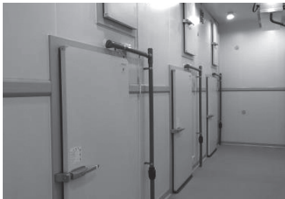
冷蔵庫内及急速冷凍庫扉
