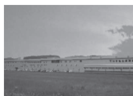
相内玉ねぎ集出荷施設
