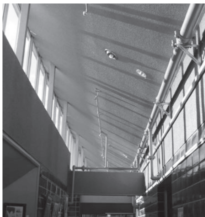
スプリンクラー設備工事
