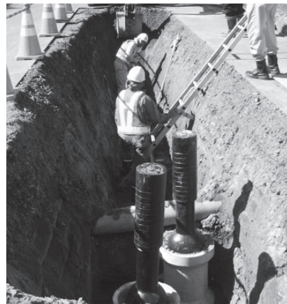
配水管布設替工事
