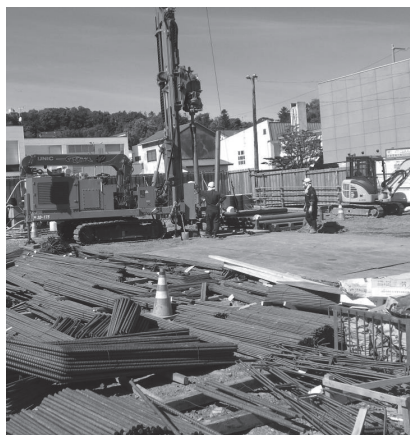
地中熱ヒートポンプ工事
