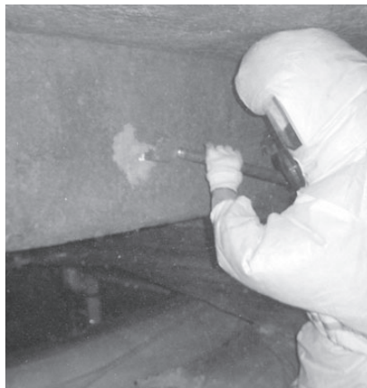
アスベスト除去工事
