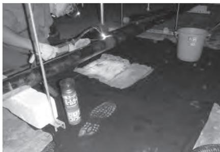
冷媒配管溶接状況(銅管)
