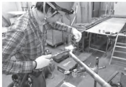
冷媒配管溶接状況(銅管)
