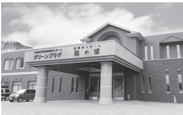
老人ホーム新築工事
