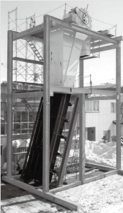
水処理場向／除塵機(下部仮組時)
